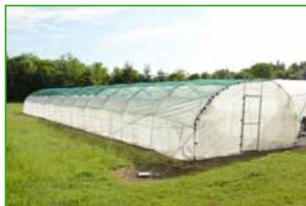
Tunnel con rete antinsetto (anno 2014)
